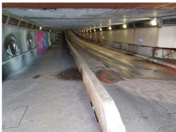
Tunnel de la Gare : Existant
